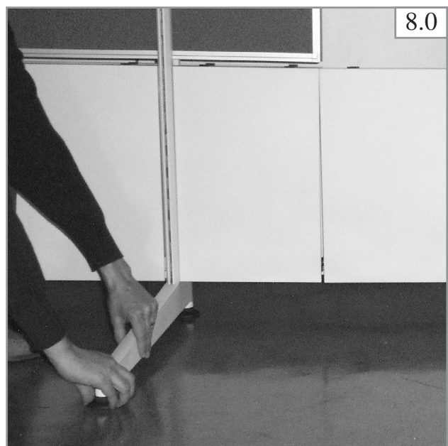
FreeWall nivelieren. Level out FreeWall. Niveler l'ensemble.
