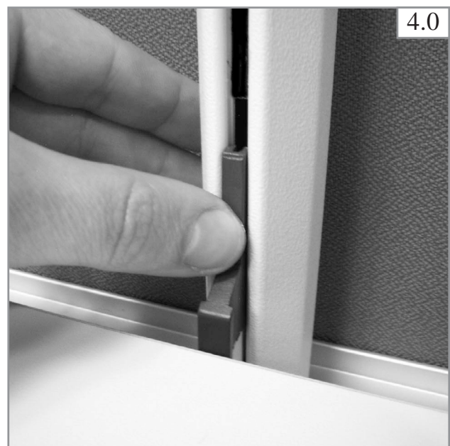
Aushängesicherung einklipsen. Attach retainer. Bloquer la fixation avec le clip de sécurité.
