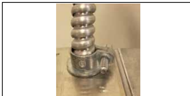
Figure 6. Raccord non ferreux de la boîte de jonction (non réparable par l'utilisateur)
