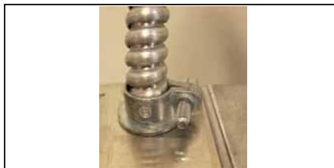
Figura 6. Accesorio no ferroso en la caja de derivación (el usuario no puede realizarle tareas de mantenimiento)
