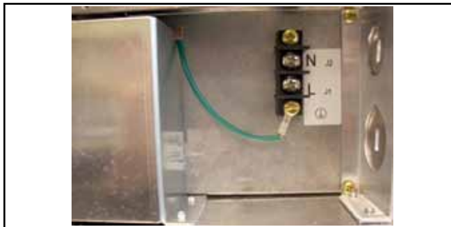
Figure 7. Connexions du câblage de la boîte de jonction
